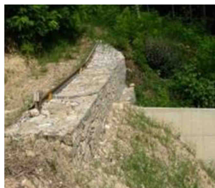
Figura 23: Gabbioni posizionati a Poiate di Farra d'Alpago.
