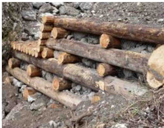
Figura 33: Particolare costruttivo della prima briglia.
