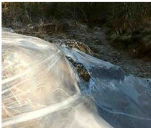
Figura 11: Impermeabilizzazione temporanea con un telo per allontanare l'acqua.
