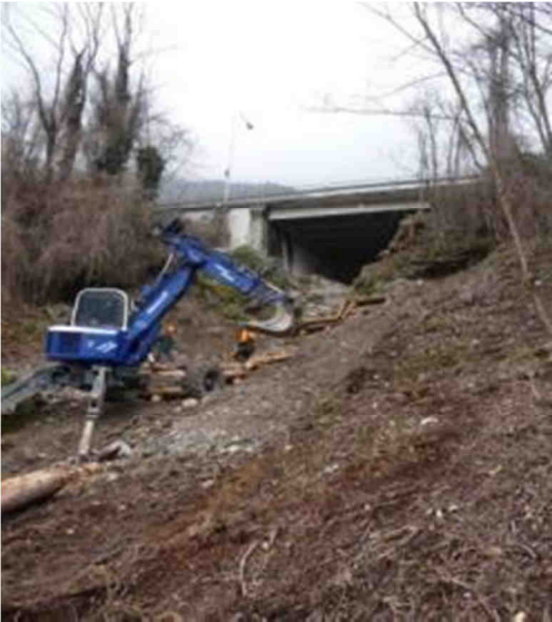
Figura 31: Visione d’insieme della fase di cantiere nel quinto caso in esame, località Fortogna,
