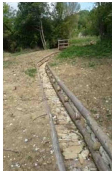
Figura 24: Canale a seguito della manutenzione e della costruzione del nuovo fondo.
