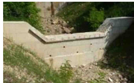
Figura 19: Briglia realizzata in località Poiatte di Farra d'Alpago.
