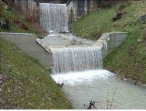
Figura 46: Briglia di contenimento a Poiatte.
