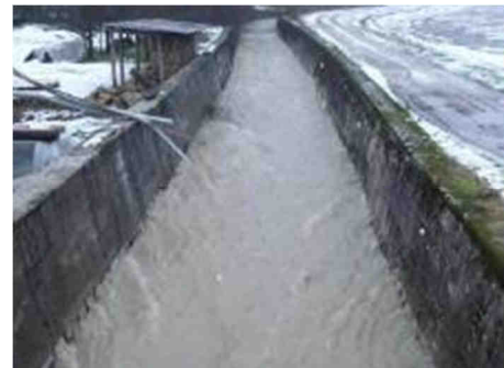
Figura 48: Torrente Valda a seguito di intense precipitazioni.
