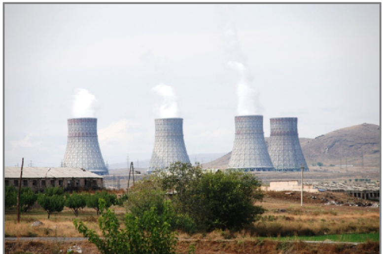
Foto 4 – La Centrale Nucleare di Metsamor e le sue due unità di generazione: dopo la chiusura del febbraio/marzo 1989, il secondo reattore (a sinistra) è stato riattivato nel 1993 ed è entrato nuovamente in funzione nel 1995, il primo reattore (a destra) invece è rimasto chiuso.
