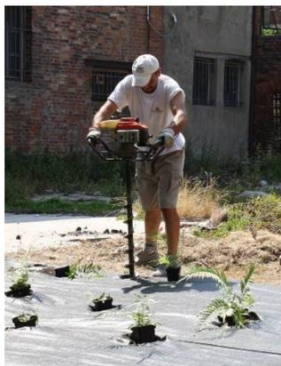
Figura 44. Realizzazione dei fori per la piantumazione.
